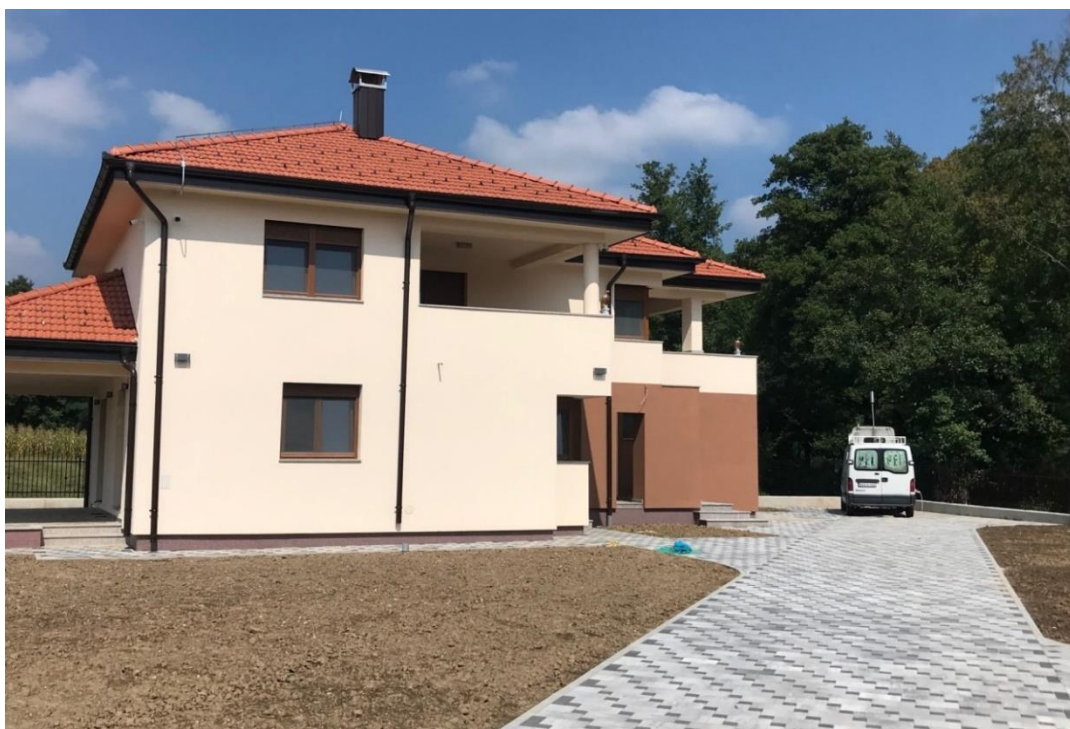
Слика 10. Мјерна локација бр. 2.
